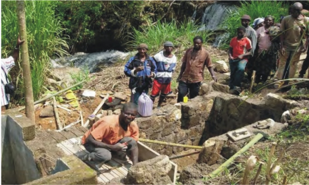
Obere odo mmiri na enye oku nke no na obodo Cameroon. Odo mmiri a adighi akpata oke ide mmiri. Ndi obodo kwere ike iru nke a na onwe ha na-enweghi nkwado obula nke di oke mkpa maka oke odo mmiri na-enye oku. O bu Terri Hathaway sere foto nke a.
